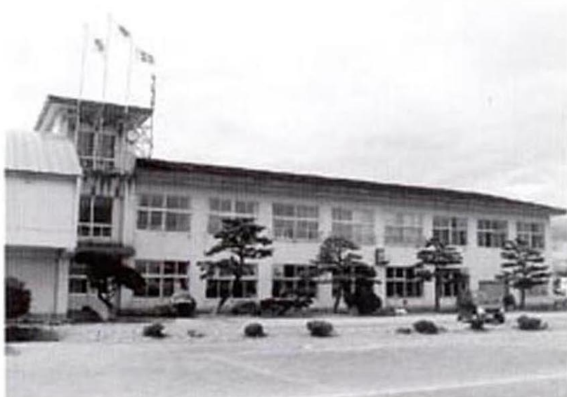
早急な建て替えが望まれる西南中学校
