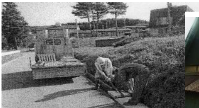
(側溝の蓋設置風景)
