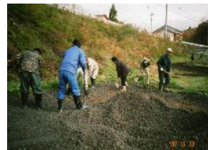
(駐車場等整備風景)
