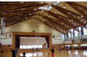
←体育館 木造一部 RC 造平屋建
