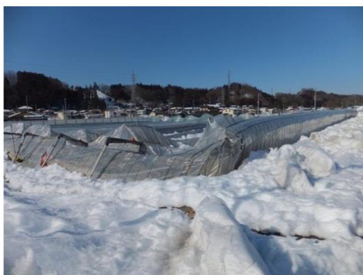
連棟パイプハウスの倒壊
