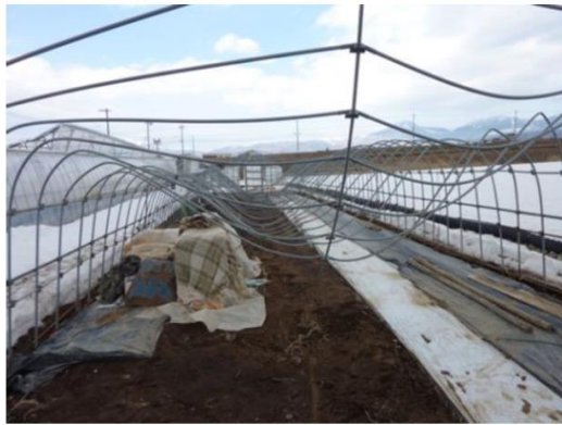
単棟パイプハウスのM字型陥没
