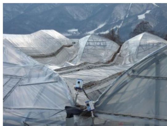
連棟パイプハウスの倒壊
