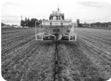
暗渠排水工事中の圃場
