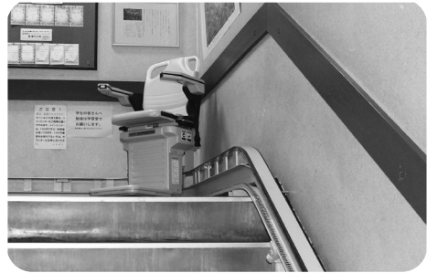
公共施設のバリアフリー化で設置された 花巻図書館階段の椅子型昇降機
