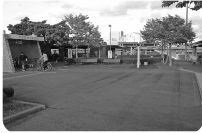
花巻駅西口。改札口のある東口へは地下道で連絡
