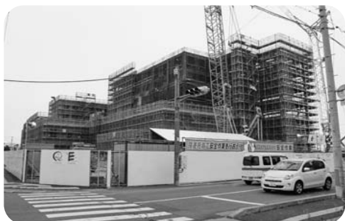
着々と工事が進む総合花巻病院建設事業
