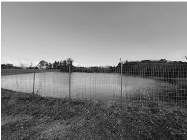
写真3 大畑ため池(西側から東側を撮影)
