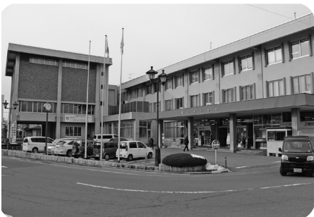
昭和45年建築の市役所本館
