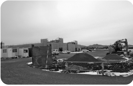
9月開業に向けて工事が進む道の駅「はなまき西南」
