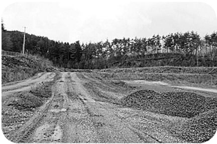
東和町平山地区にある市廃棄物最終処分場
