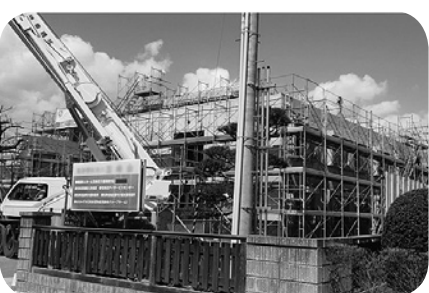
建設中の地域密着型特別養護老人ホーム
