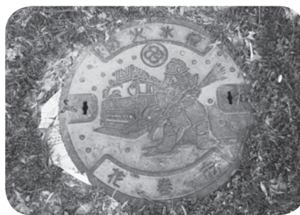
防火水槽の調査が始まります
