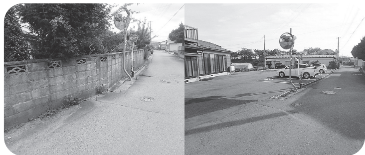
危険なブロック塀の撤去前（左）と撤去後（右）
