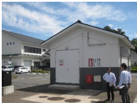
道の駅内の自家発電施設
