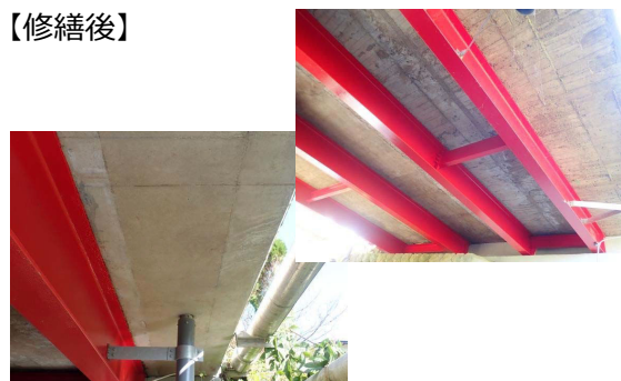
【対策内容】床版部分打換え/塗替塗装
