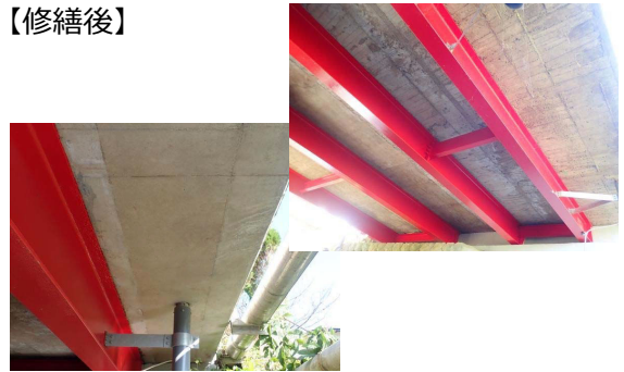
【対策内容】床版部分打換え/塗替塗装
