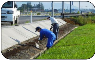
植栽床に培土を混ぜ込み
