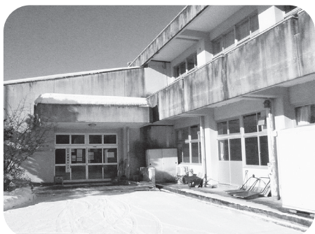
老朽化が課題となっている田瀬振興センター
