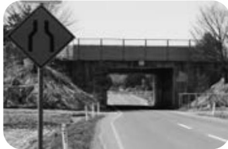
安全確保が指摘されている花巻市総合体育館に通じる高速道路下の市道
