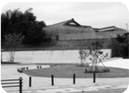
惜しまれながら解体が始まった旧料亭「まん福」(写真上方)
