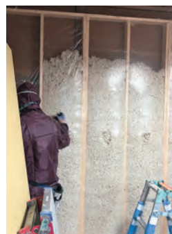
▲中古民家での断熱リノベーション。断熱材(ロックウール)を満たしています
