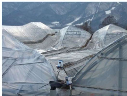
連棟パイプハウスの倒壊
