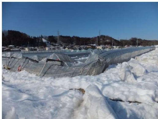
連棟パイプハウスの倒壊
