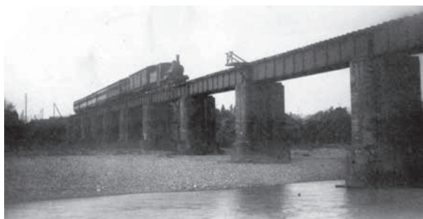
豊沢川を渡る東北本線の機関車両
