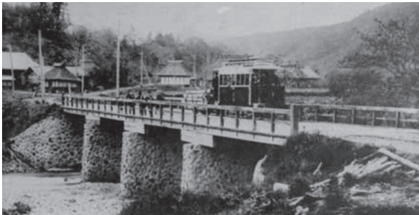
渡橋と鉛線（大沢温泉停留所付近）
