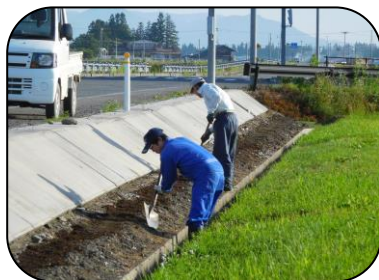
植栽床に培土混ぜ込み作業
