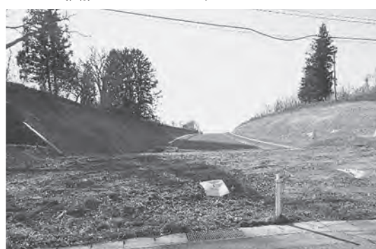
整備が進む都市計画道路山の神諏訪線1工区 (和同産業南側付近、令和3年4月1日)
