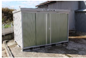
土沢第3区自治会 倉庫新設
