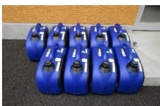
発電機のオイルを交換
