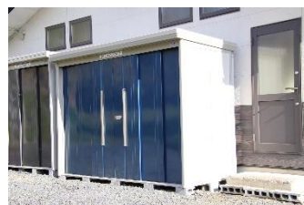
鎭町自治会 倉庫新設
