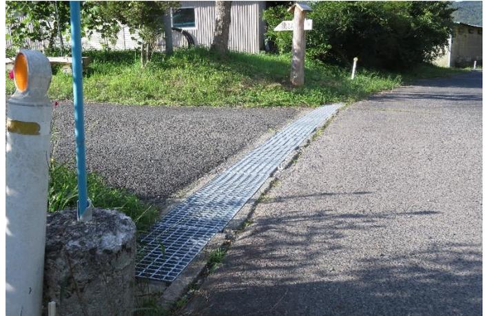
谷内第2行政区自治会では、丹内山神社さわやかトイレ横に設置されている観光案内図が経年劣化による錆等で見えにくくなっていたものを更新、側溝蓋を設置した鷹巣堂2区地内は、コンクリートブロックがもろくなり崩れていたものをグレーチングに布設替えしています。
