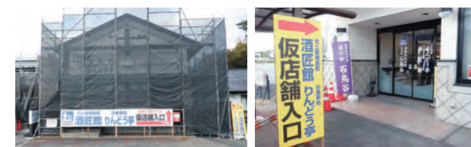
▲改修工事中の「酒匠館」
