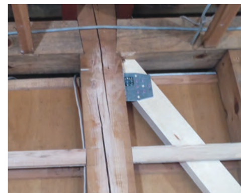
筋交いを施し、耐震化した様子
