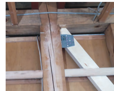
筋交いを施し、耐震化した様子
