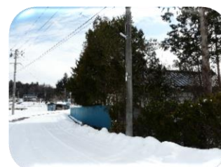
街路灯設置（新堀7区）
