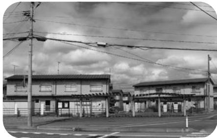
跡地活用が検討されている大谷地アパート
