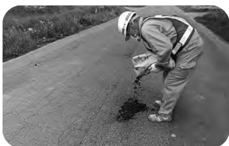
舗装剥離の補修作業
