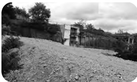
景観上の問題が指摘されている旧新興製作所跡地
