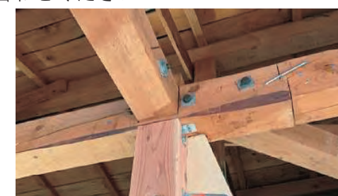
筋交いを施し、耐震化した様子
