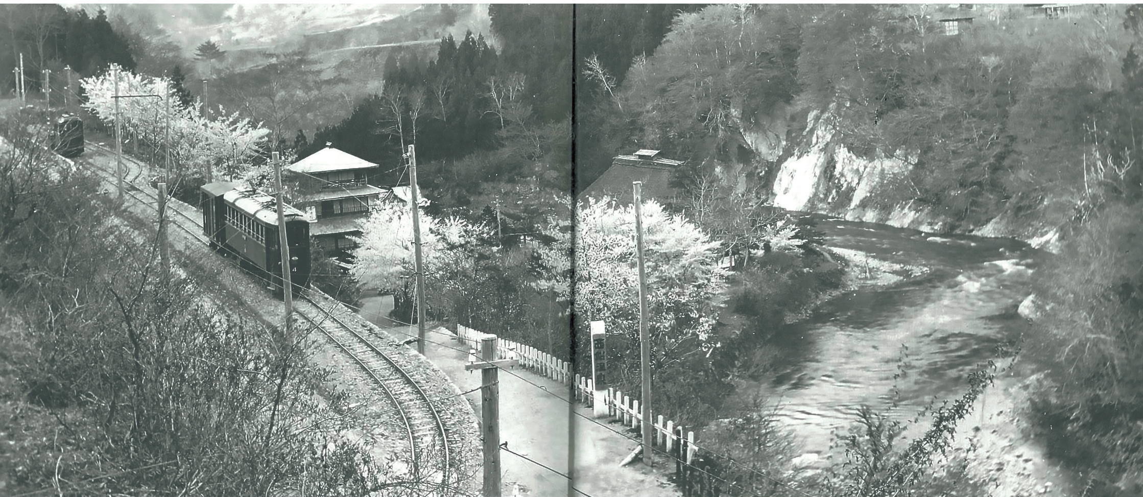
豊沢川の景観を行く鉛線電車 / 西鉛温泉駅
