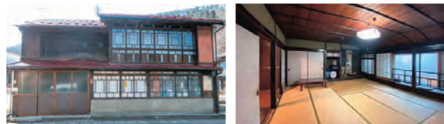
▲基礎調査を行った建物の一部
