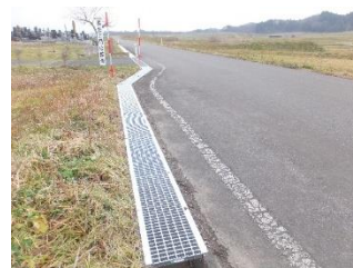
側溝蓋設置(谷1)
