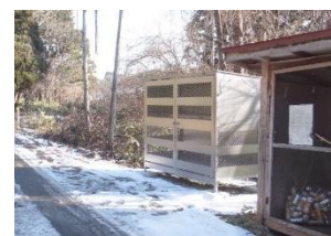
ゴミ集積所改修整備(谷6)
