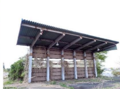
残置建築物 C(本館東側)
