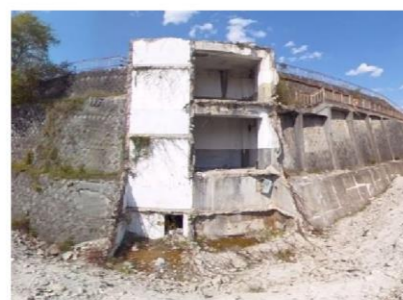
残置建築物 A (区間①)
