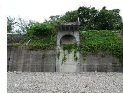
残置建築物 E (⑦区間)
