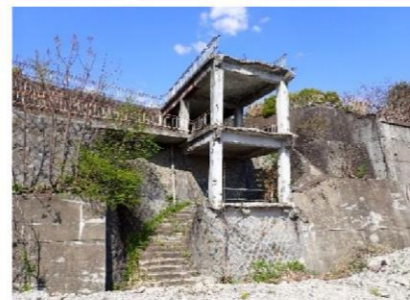
残置建築物 B (区間②)
