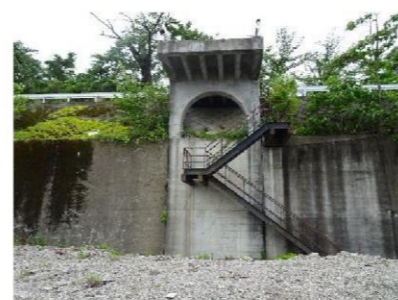
残置建築物 D (区間⑦)
