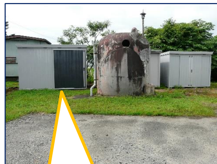
今回設置した用具保管庫
