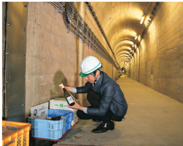
田瀬ダムの監査廊にワインを持ち込む事業者
