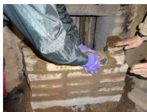
たき口。窯の煙が43° になったらたき口を閉じる
