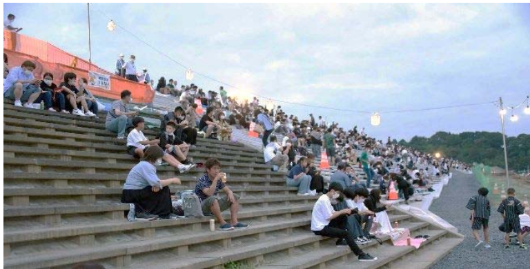
磐井川緑地（一関市）に整備された階段護岸
