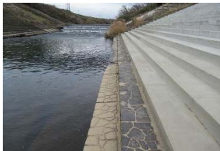
上段のステップはコンクリートで改修。下段のステップは湾曲している（左岸）
