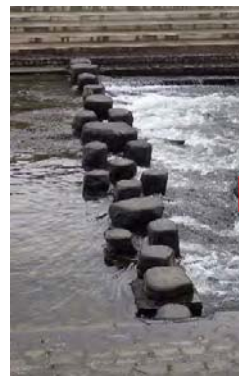
瀬川の飛び石（現況）
