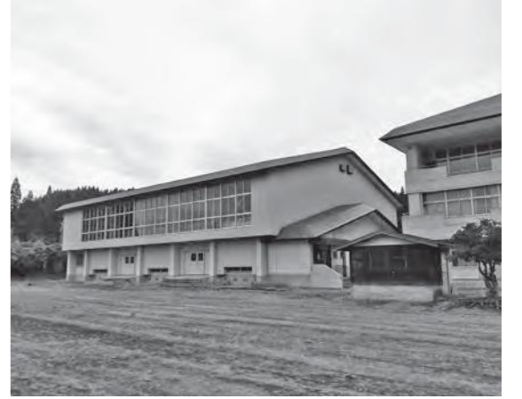
旧笹間第二小学校体育館
