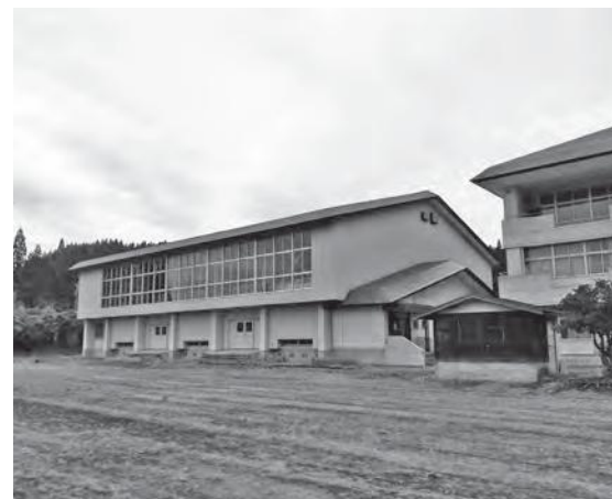
旧笹間第二小学校体育館
