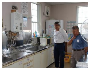
土沢自治会館 給湯給水管改修工事
