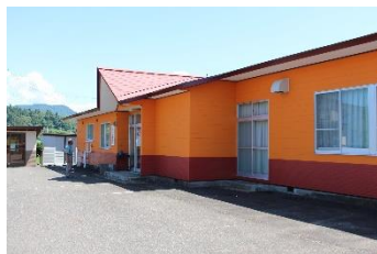
前郷公民館外壁塗装工事
