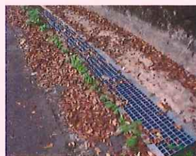
側溝にかかっている グレーチング
