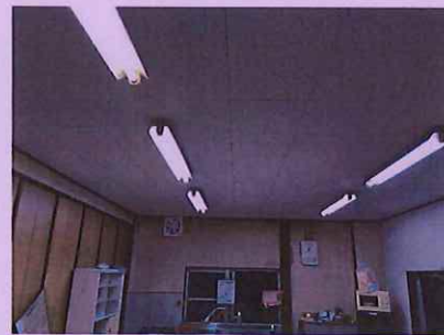
合石自治公民館 公民館天井修繕工事
